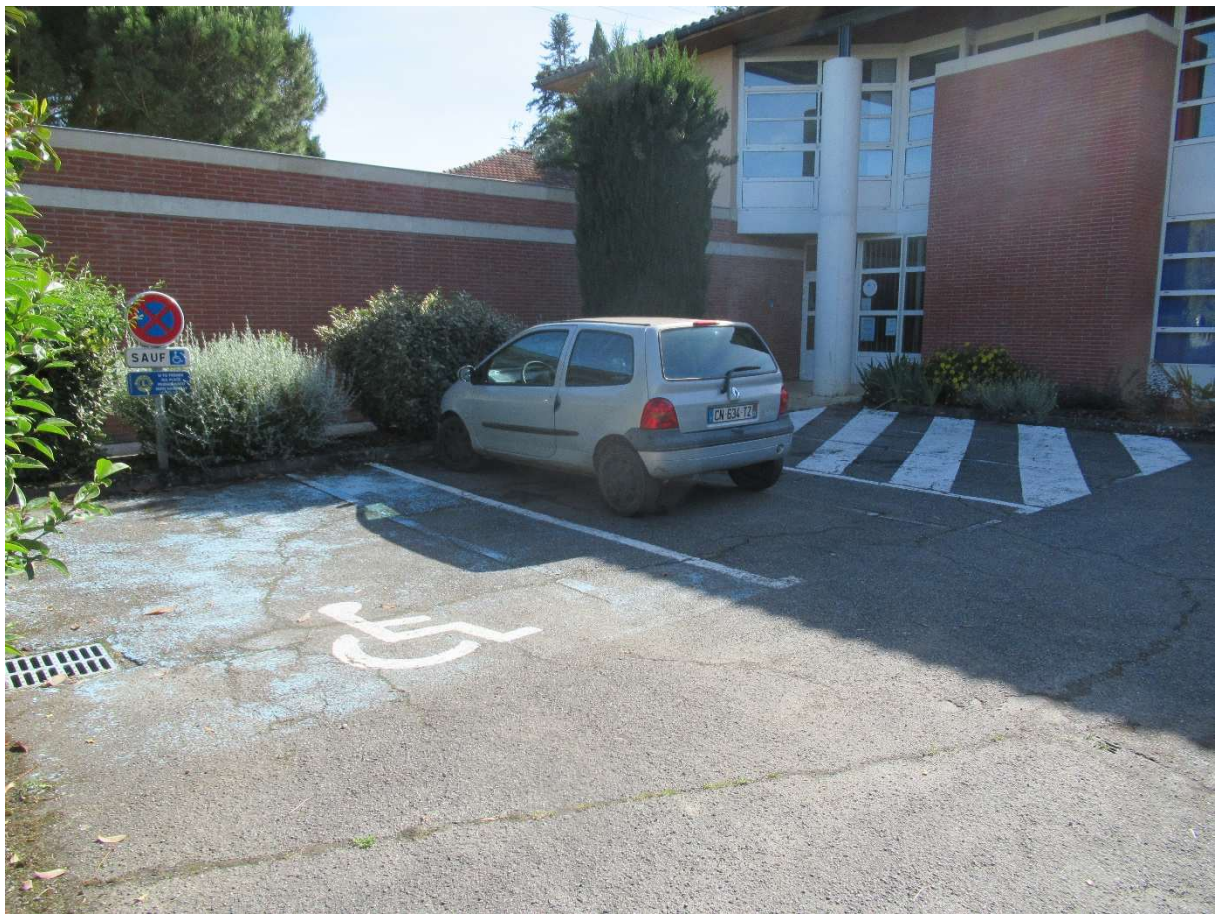
Parking réservé au public
